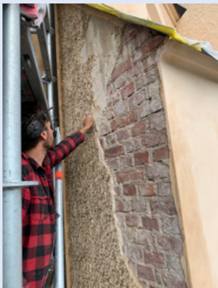
Puttskador åtgärdas på delar av Vindelns kyrka som av kostnadsskäl vårdas i omgångar. FOTO: ANNIKA LINDBERG
