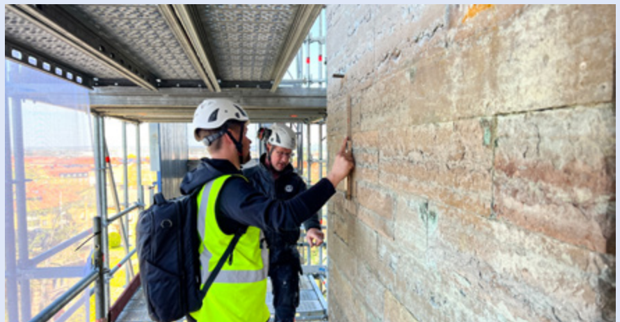
Tim Ericsson och Stefan Gullberg undersöker vilka stenar som behöver bytas.. FOTO: ROYNE MERCURIO
