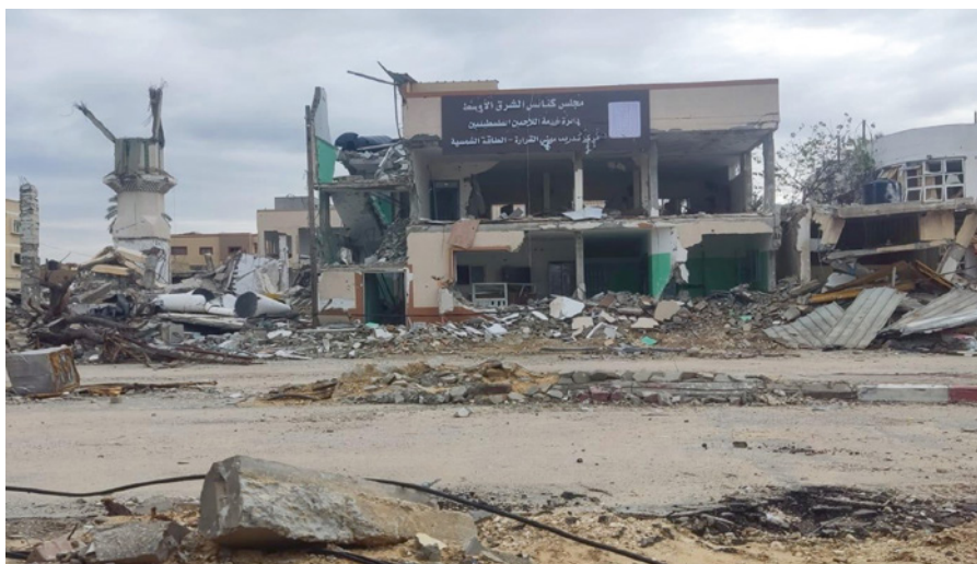
Byggnaden där en av Act Svenska kyrkans partner har bedrivit yrkesutbildning för palestinska flyktingar i El-Qarara på södra Gazaremsan har totalförstörts under kriget. Foto: DSPR MECC/Ikon
