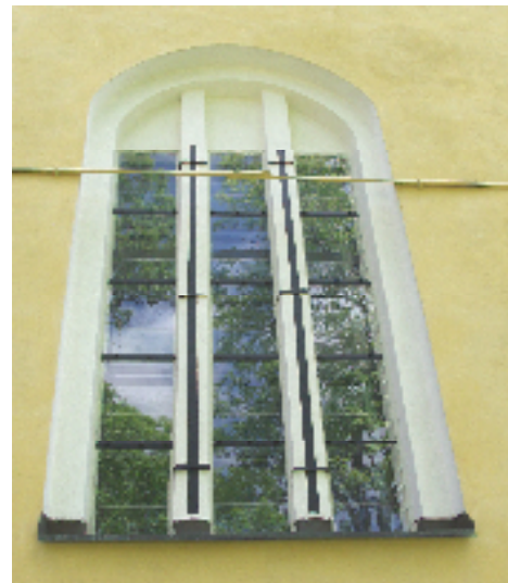
Västra gavelfönstret med järnförstärkningar i angränsande murverk – Digitalfoto Rolf Hammarskiöld
