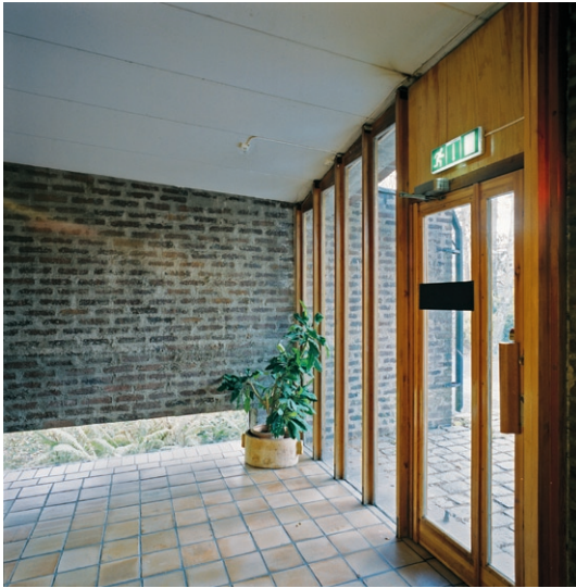
Entré till församlingsbyggnadens förhall.
