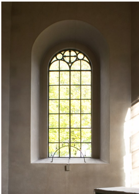
Gjutjärnsfönster i kyrkorummet.
