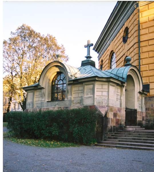
Det norra gravkoret från väster.
