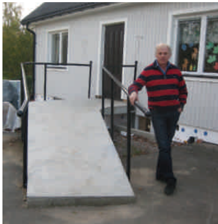
Ebbe Therén är nöjd med renoveringen av församlingshemmet.
