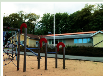
Skolan byggdes 1951, användes som byskola fram till 2009. Därefter har lokalerna gapat tomma. Men nu är den åter i bruk och används av Omsorgsförvaltningen i Hässleholms kommun som numera bedriver Daglig verksamhet.
