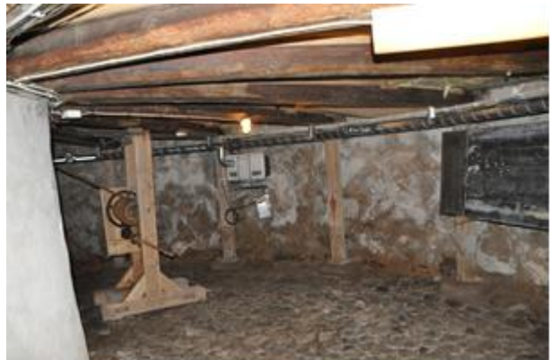
Installerat nytt avfuktningssystem i källaren på Södra kapellet
