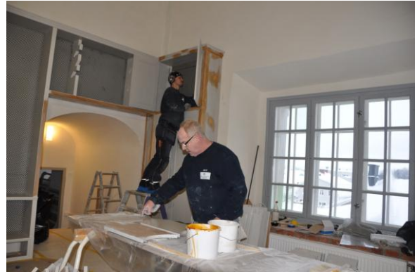
Flertalet av arbetsrummen färdigställdes under året.
