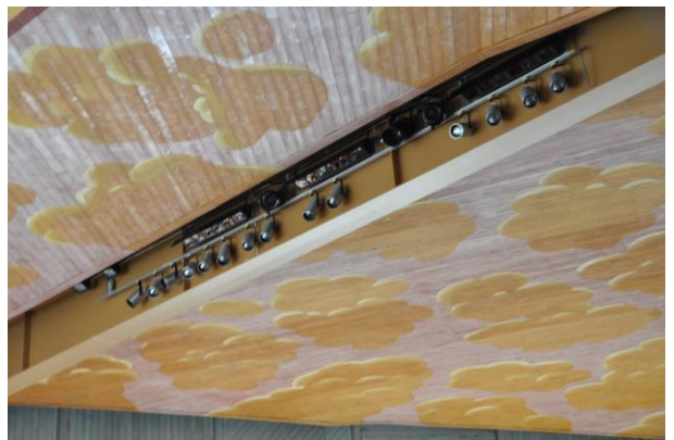
Installation av spotlights armatur i S:ta Birgitta-kyrkan
