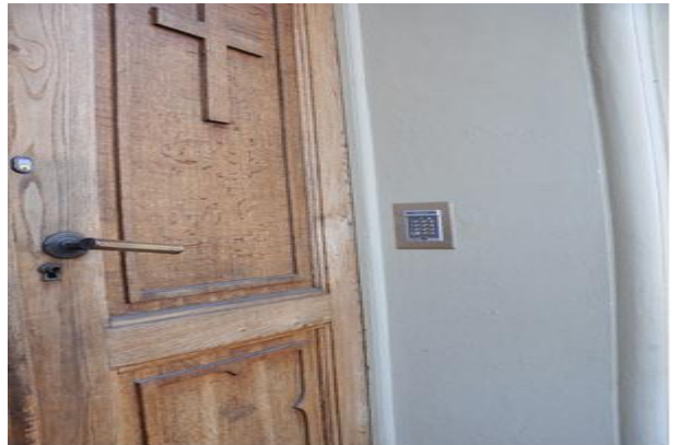
I Södra kapellet installeras digitalt låssystem
