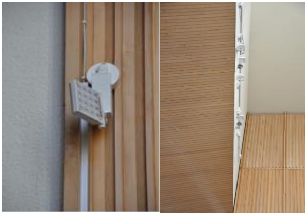
Installation av armaturer med spotlights funktion i koret i Heliga Korets kyrka
