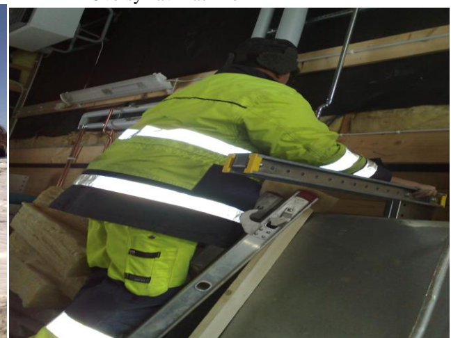
Isolering av garage.
