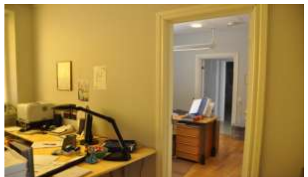
Tidigare större rum avdelat med ny vägg och dörr, domprostgården nedreplan.
