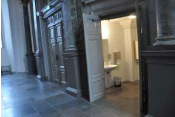
Östra delen av domkyrkan färdigställs med nytt samtalsrum, personalrum oh WC.
