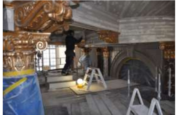
Guldbeläggning av tak under orgelläktare och orgelfasad .
