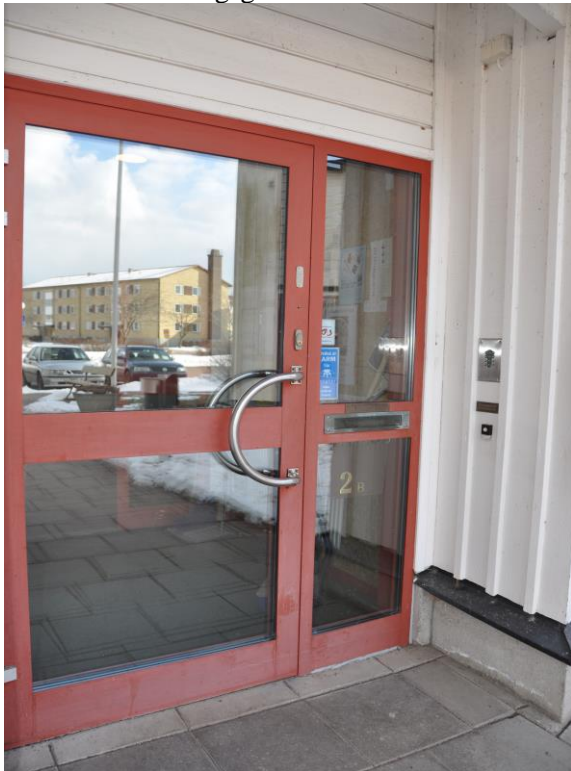
Installation av digitalt lås- och larmsystem.
