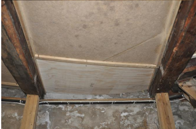
Nytt avfuktningssystem, nya elledningar, armatur samt förbättrad isolering i golvbjälklag
