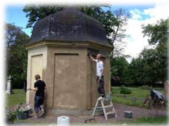
Stagnellska gravkoret renoverats
