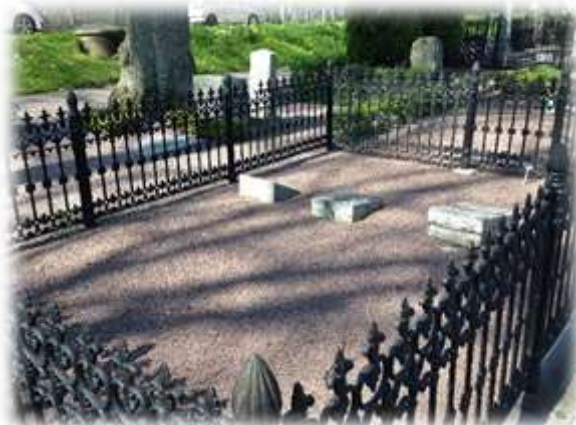
Projekt tvättning och målning av gjutjärn på Södra kgd
