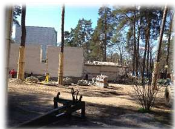
Krematoriet under full byggnation
