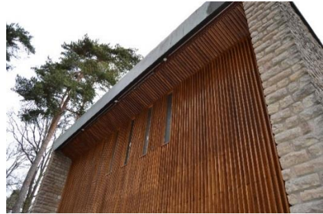
Ny LED belysning installerad
