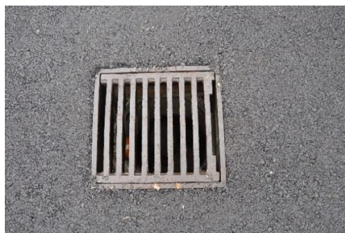
Brunnslock samt utjämnande asfaltsbeläggning
