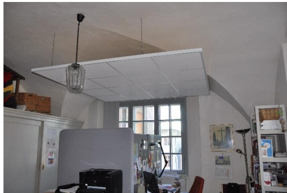
Ljudisolerande plattor i ett arbetsrum
