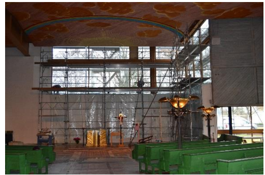
Varma fönster installeras
