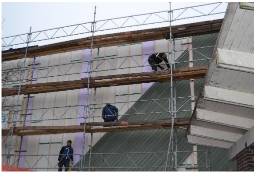
Träpanelen byts ut
