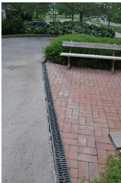
Dräneringskanal som är sammankopplad med brunnen
