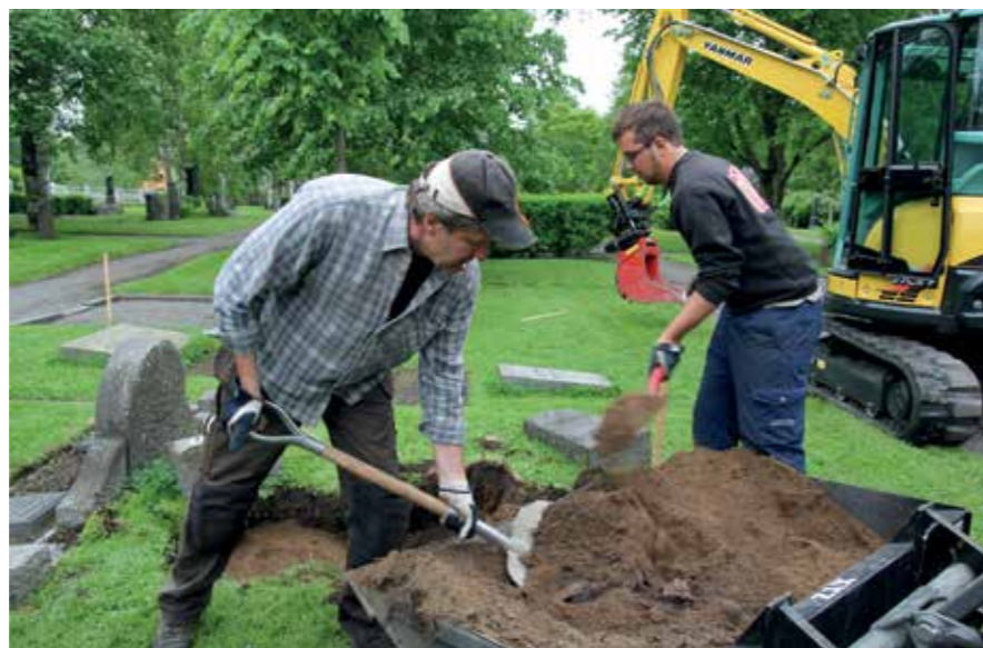
Daniel Lönnefjord (t v) och Linus Sandström förstärker gravstensfundament på Västra kyrkogården.
