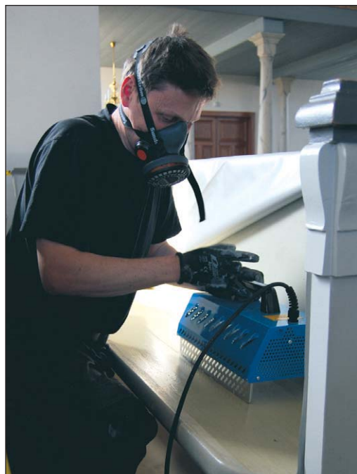
Den gamla färgen värms bort.
