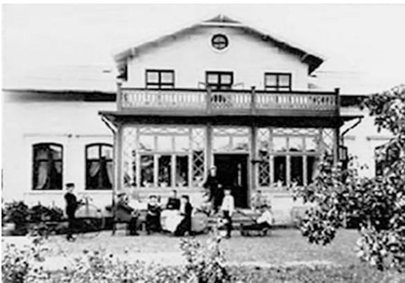
Weibullsholm som det såg ut i slutet av 1800-talet med den veranda som sedan funnits med i framtida ombyggnader.
