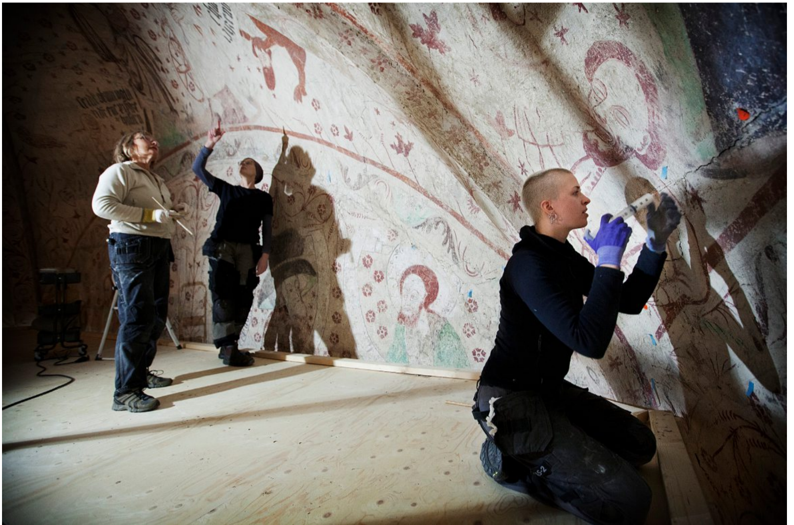
KALKINJEKTION. Konservatorerna Anna Brandi, Misa Asp och Elin Lundmark arbetar med att renovera målningarna i Ärentuna kyrka. Elin Lundmark i förgrunden använder sprutor för att trycka in kalk bakom putsskicket där det lossnat från kyrkoväggarna.
