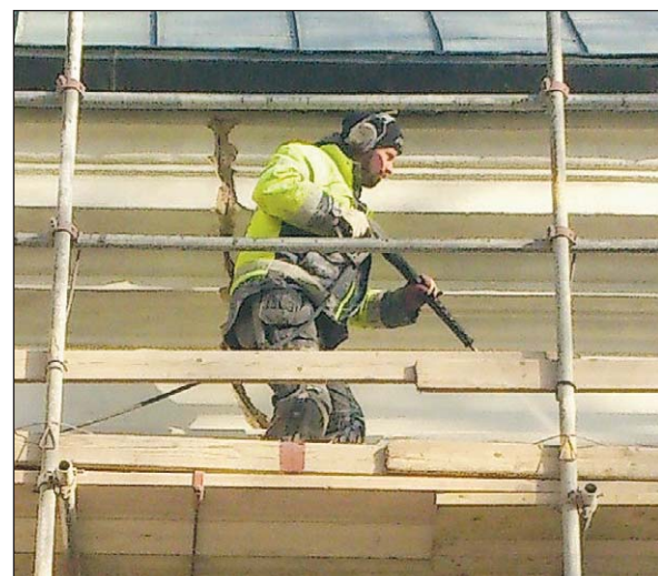
Här sprutas fasaden ren från löst sittande putsrester och damm innan det är dags att gå på med ny puts.
