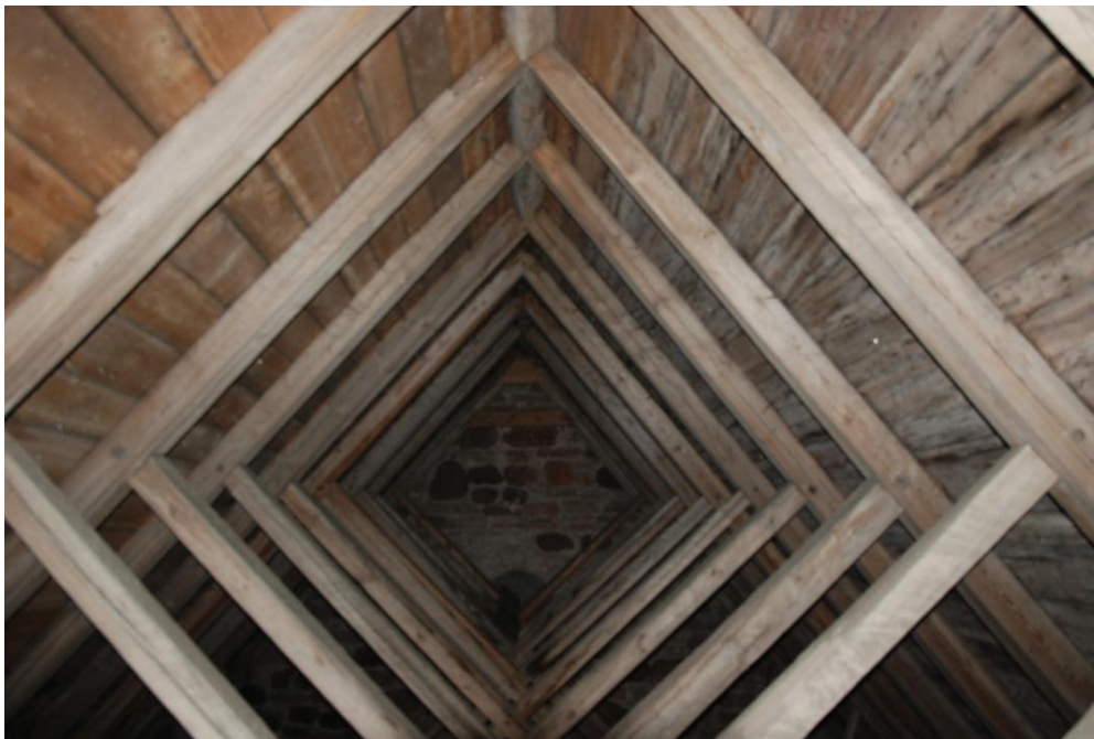
Bild 2: Högben, stödben ochnockås i den romanska takstolen från slutet av 1100-talet. Vy mot väster.
