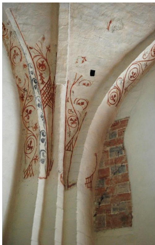
Bild 2: långhusets sydöstra hörn med målat tegelmönster
