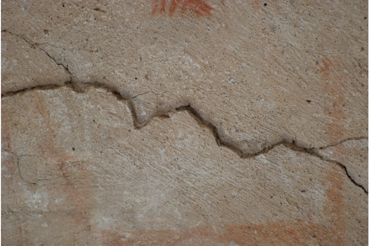
Bild 7: spricka i korvalvets södra valvkappa, fotograferat med teleobjektiv. Det är oklart om sprickan är kantlagad eller om skadan har uppkommit efter 1990-talets konservering. Förnyad besiktning behövs.
