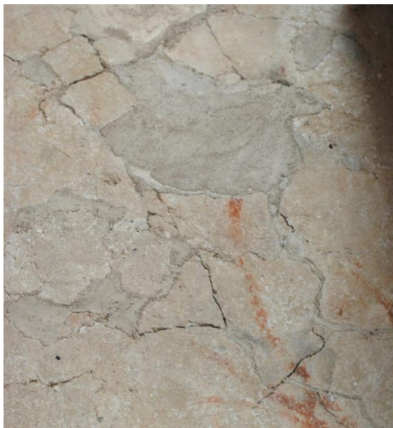
Bild 20: detalj av sprickbildning, delvis kantlagad, i korvalvets östra kapp.
