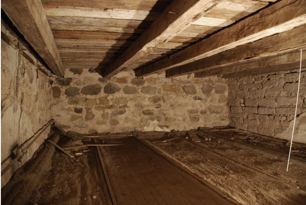
Bild 17: utrymmet mellan sakristia och tornvåning, vy mot norr.
