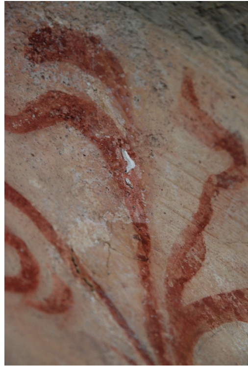
Bild 3 (tv): längst in vid den murade fönsteromfattningen sitter lösa putsbitar som behöver fästas.
