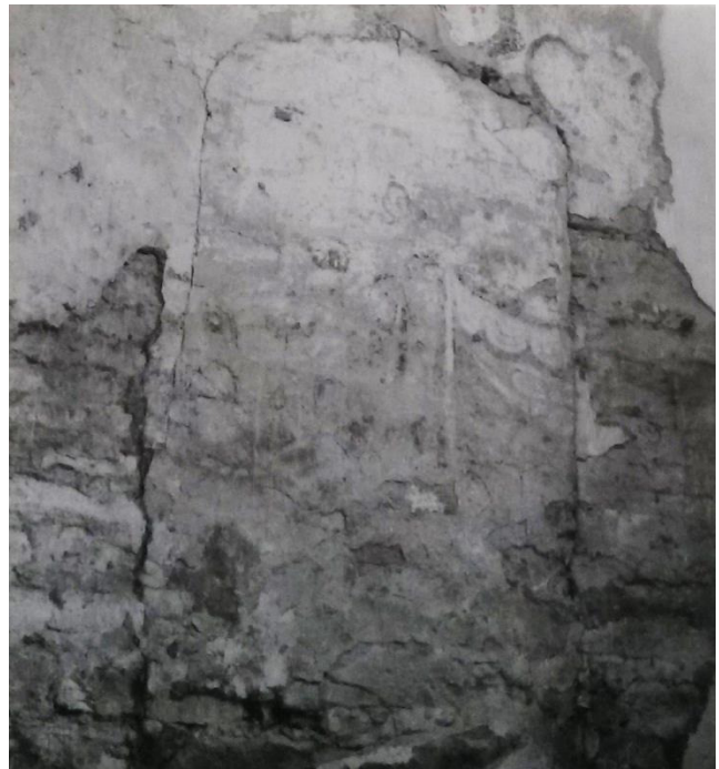
Bild 16: Sakristians sydvägg, draperimålning över den igensatta ingången. Foto ÖLM 1968
