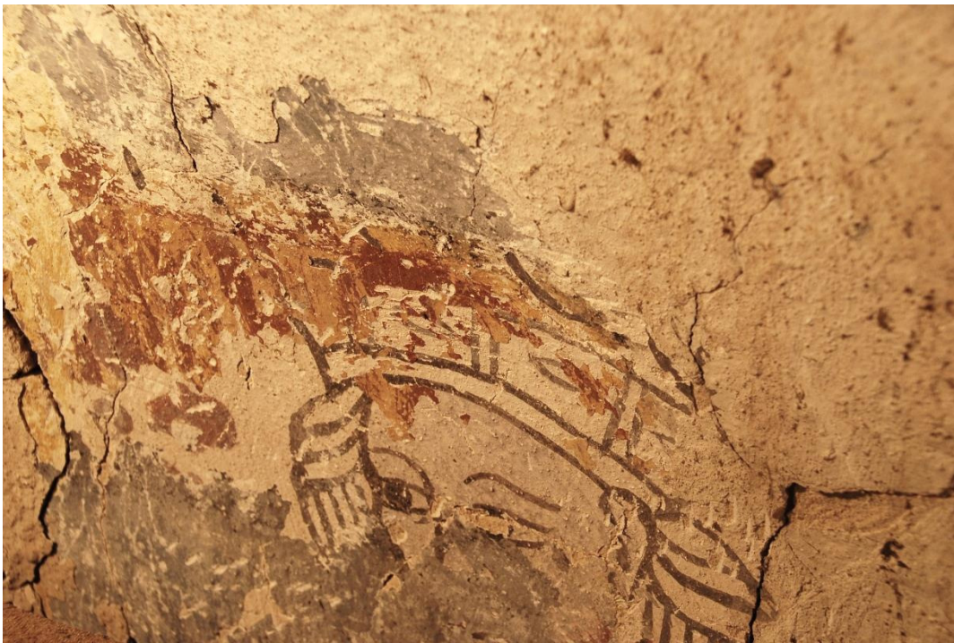
Bild 18: detalj av måleri på västra väggen, ett kungaansikte som kan ha tillkommit samtidigt som det nu överkalkade måleriet på sakristians västvägg (bild 15). Preliminär tolkning av färglagren är 1) rött/orange, heltäckande färgskikt, 2) vitkalkning med grått figurmåleri och röd dekor, 3) blågrått måleri med mörkare gråa linjer, 4) överkalkning med en mörkt grå rand längs kanten av putsen.
