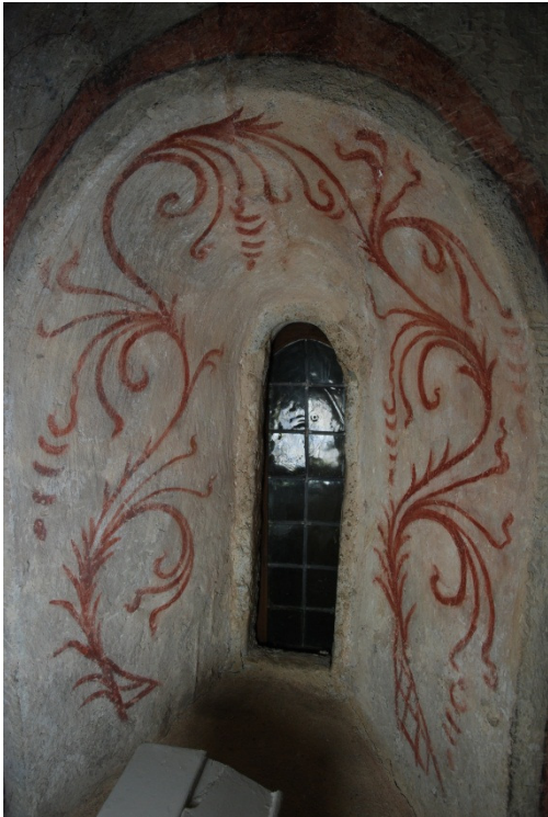
Bild 3 (tv): längst in vid den murade fönsteromfattningen sitter lösa putsbitar som behöver fästas.
