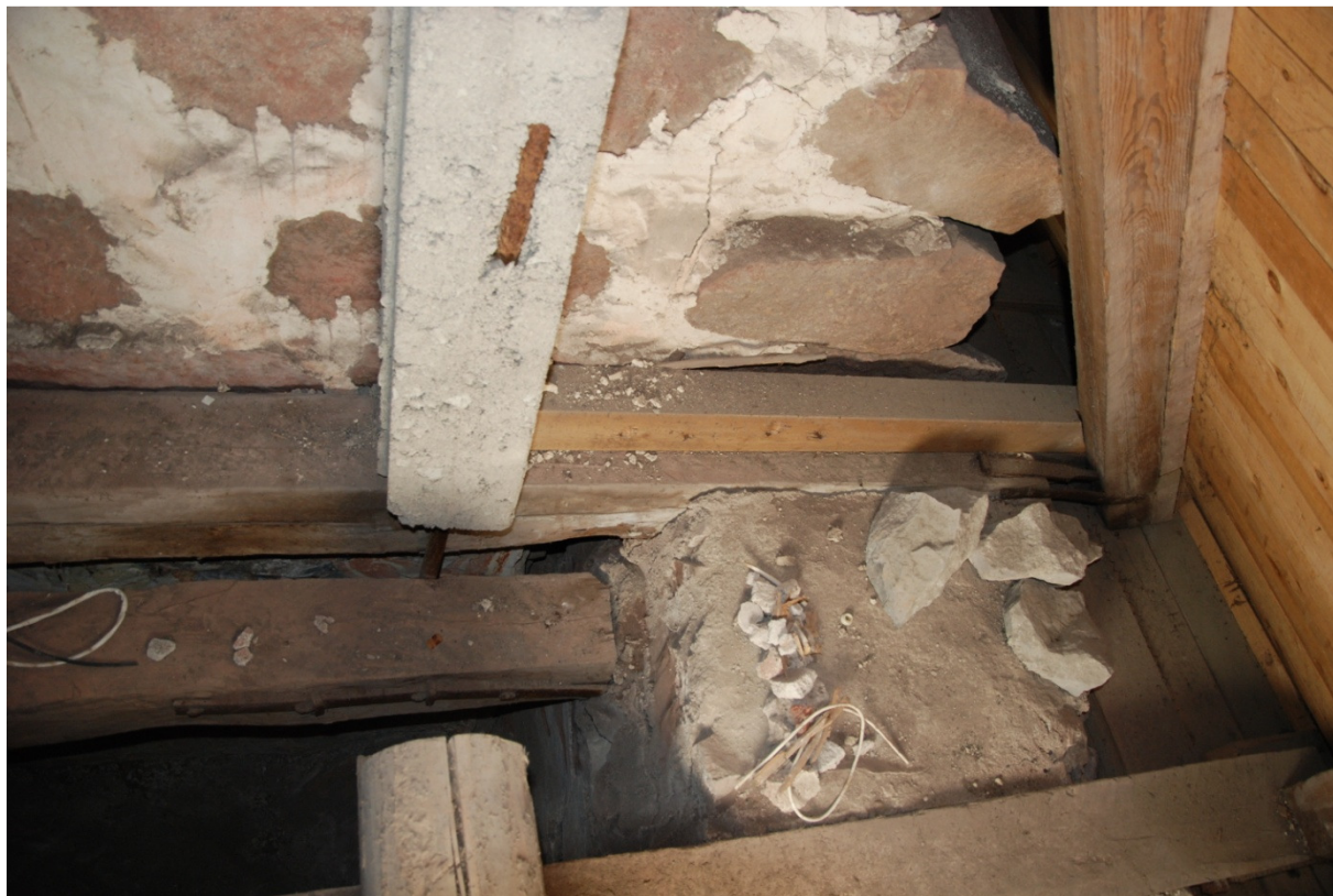
Bild 9: sydöstra långhusmuren, förstärkningar av takstolen
