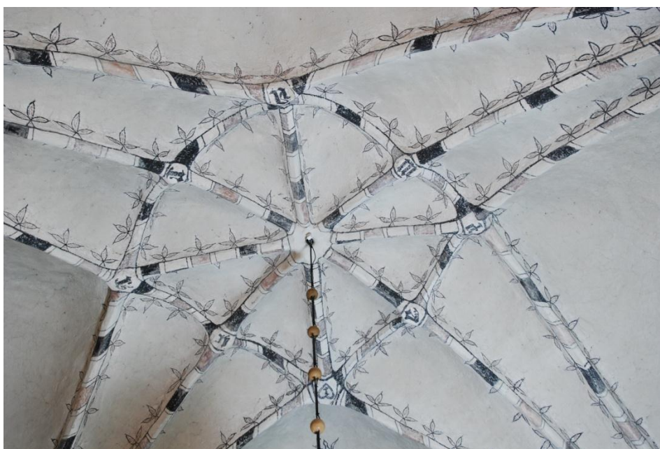
Bild 6: stjärnvalvet i det senmedeltida koret. Stenarna vid ribbornas skärningspunkter har försetts med varsin bokstav, tillsammans bildande inskriften "maria i xp", dvs Maria Jesus Kristus
