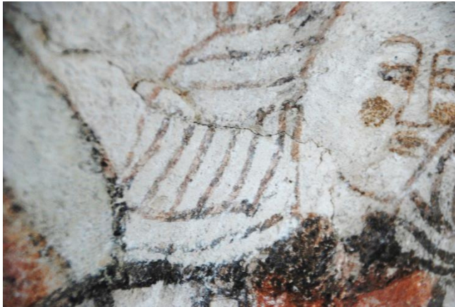
Korets nordvägg, exempel på skador. T.v. spricka, t.h. färgbortfall
