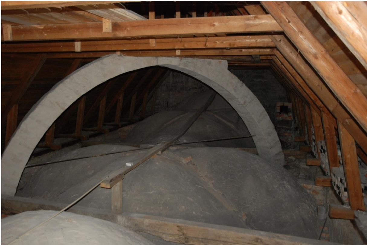
Bild 4: långhusvinden under gångbron, vy mot väster.
