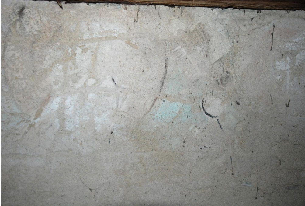
Bild 7: östra långhusväggen ovan valv.
