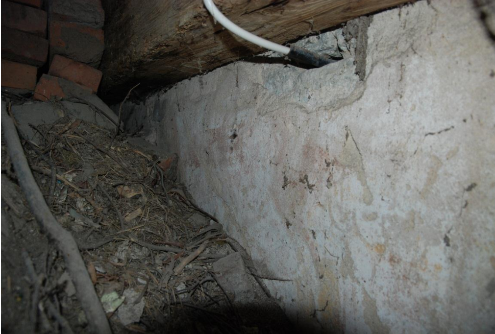
Bild 9: elkabel som dragits igenom långhusets östmur.
