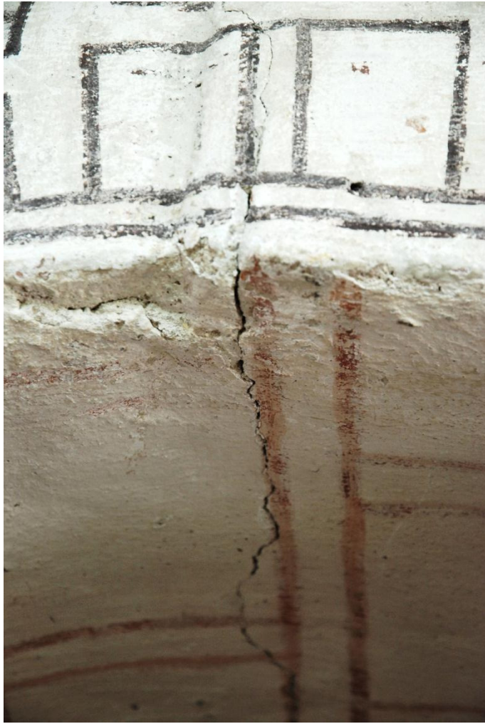
Bild 11: Detalj av sprickan över sakristieportens valv.
