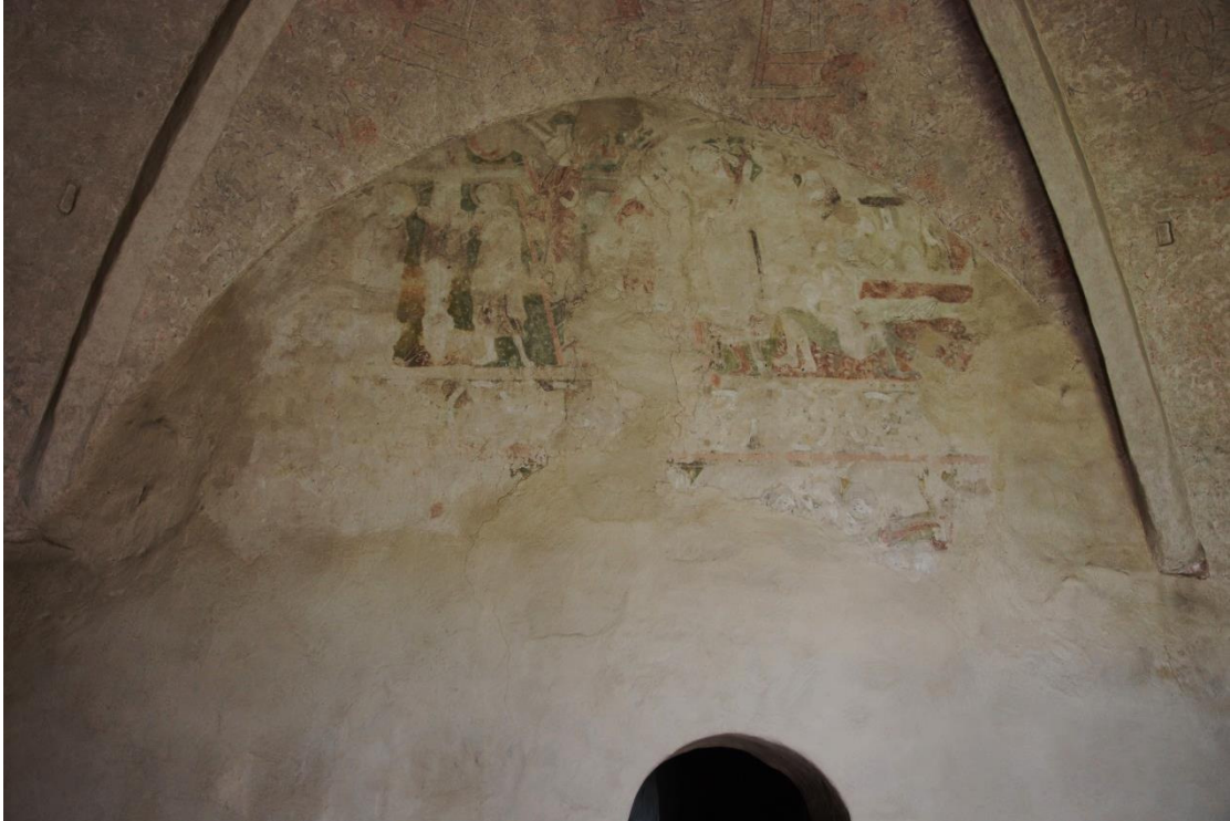
Norra korväggen, översikt.
