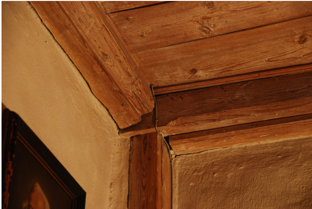
Våning 1, nuvarande sakristian. Till vänster detalj av sydöstra hörnet, nedan översiktsbild med takbrädningen.
