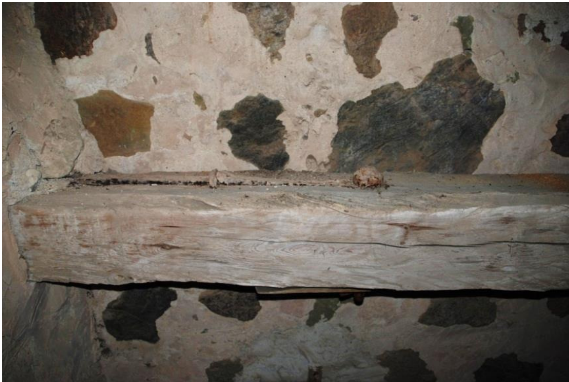
Dragbjälke på våning 4, sannolikt från 1700-talet
