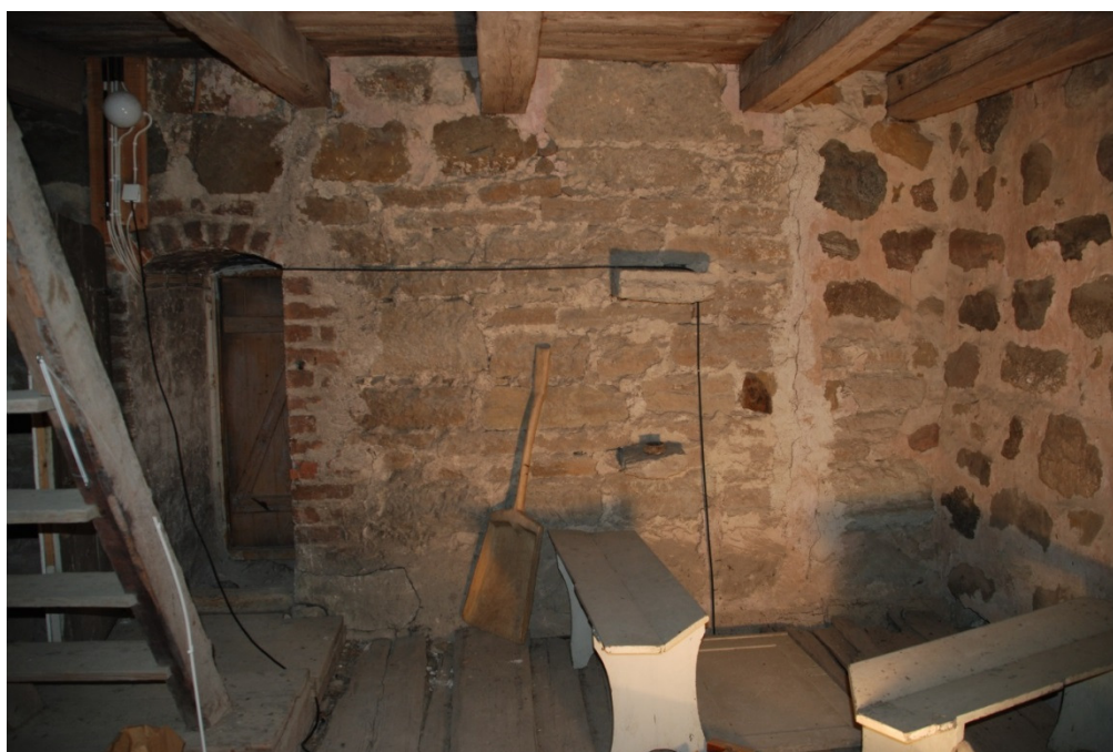
Våning 3, södra halvan av tornets östra mur, med sekundär genombrytning och med övergången från kalkstens- till fältstensmurverk. Notera de bägge utstickande förtagningstenarna i kalkstensmurverket.
