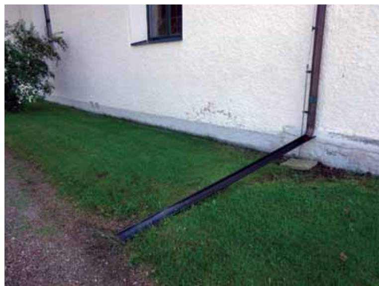
Avledningen av regnvattnet har flyttats ut från fasaden.
