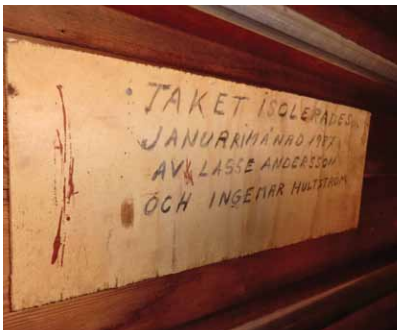
Tydlig dokumentation av tilläggsisolering.
