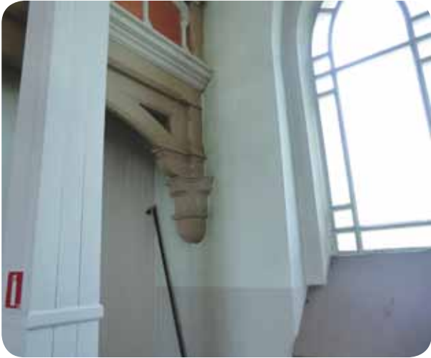
Infästning av läktaren vid yttervägg i Nya Bokenäs kyrka.
