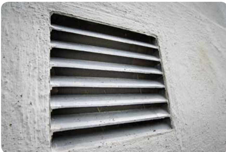
Ventil med insektsnät i grundmuren.
