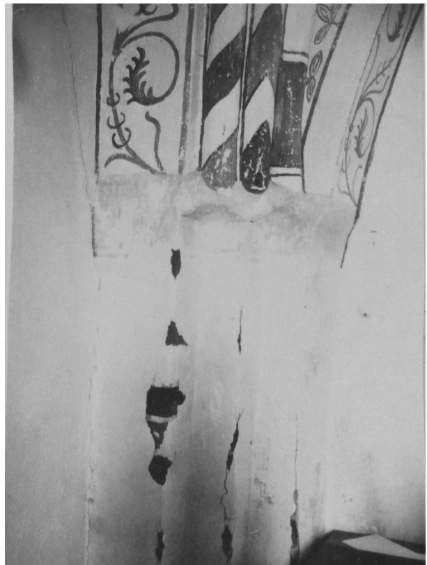
Nordvästra valvanfanget. T.v. nuläge, t.h. 1980 (foto Jonna Stewenius ÖLM). Den vänstra blomstergirlangen har skador i putsen.
