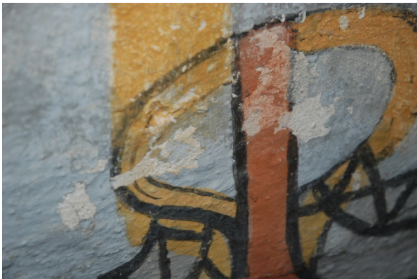
Skador på altarets puts och färgskikt. Nere t.h. är nedre delen av altaret med äldre retuscher men med ytterligare bortfall bredvid retuscherna
