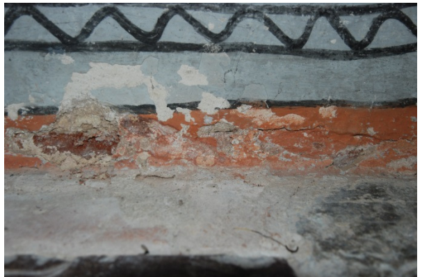
Skador på altarets puts och färgskikt. Nere t.h. är nedre delen av altaret med äldre retuscher men med ytterligare bortfall bredvid retuscherna
