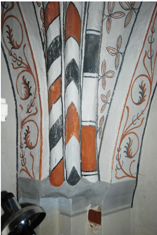
Nordvästra valvanfanget. T.v. nuläge, t.h. 1980 (foto Jonna Stewenius ÖLM). Den vänstra blomstergirlangen har skador i putsen.
