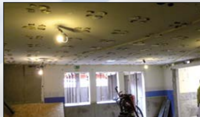
Hela tiden sker det arbete inomhus. Här har man tagit upp dörren till det nya rummet i barn och ungdom. 2015-05-12
