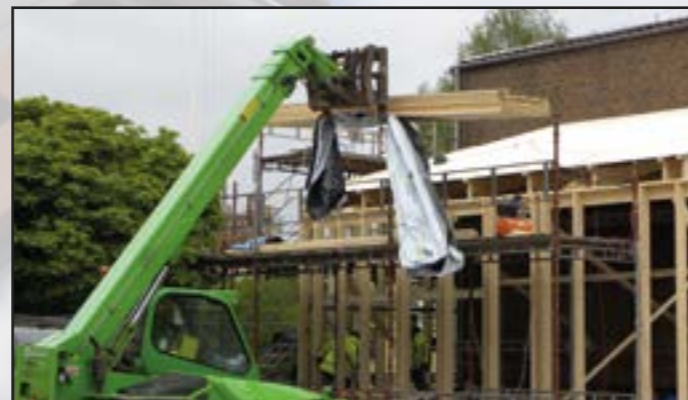
Andaktsrummet har fått början till väggar och tak. 2015-05-22
