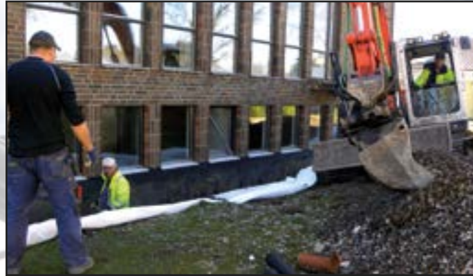
Här pågår dräneringsarbete på baksidan av församlingshemmet. 2015-04-21
