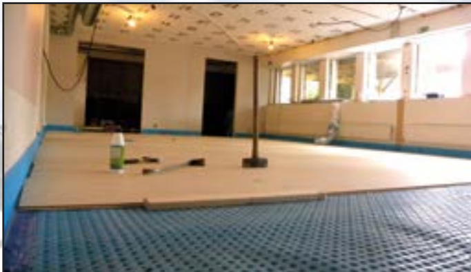
Vikväggen i bottenvåningen är borta. Nytt golv läggs och i bakgrunden ser vi öppningarna till de nya stora förråden, 2015-07-06
