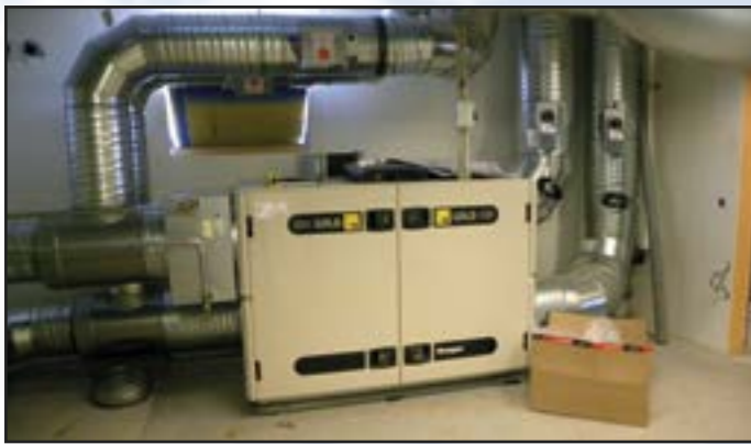
Fläktsystemet behöves förbättras. Ett nytt system kommer på plats och nya fläktrum har kommit till. 2015-06-22
