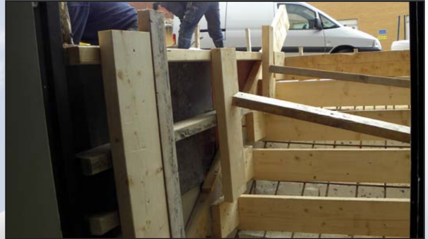
Trappan ner till barn och ungdom är på plats. Här ser vi redan att vi får en bättre ingång från framsidan. 2015-05-26
