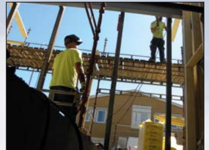
Den nya entrén har här fått sina stålbalkar snart på plats. Till höger skimtar vi också dörröppningen till andaktsrummet från entrén. 2015-06-12
