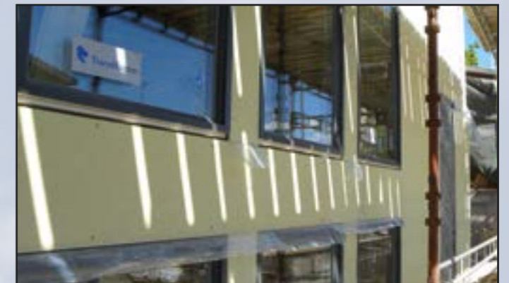
Fönster på plats. Här har vi fått fönstren till andaktsrummet monterade, väggen kvar och platsen där man skall kunna gå in från gatan syns till höger. 2015-06-09
