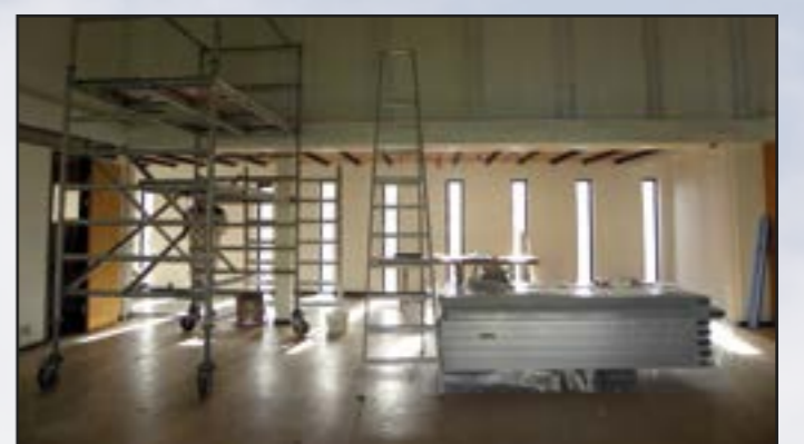
Målningsarbete i stora salen. Alla tak och väggar är snart grundmålade. 2015-03-31
