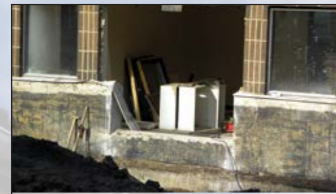
Ett stort hål togs upp i väggen och runt detta har sedan den nya utbyggnaden under ett halvår tagit form. 2015-03-24
