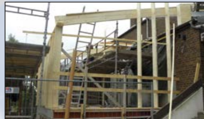
Ovanför det nya rummet i barn och ungdom kommer det finnas ett rum som skall fungera som bland annat samtalsrum. Här är trappan på sidan fortfarande kvar. 2015-06-02
