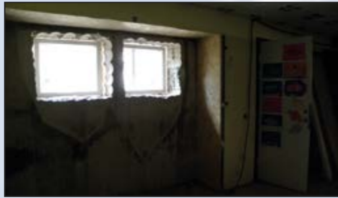
Nya fönster i barn och ungdomslokalerna, här i väggen mot pastorsexpeditionen. 2015-06-26
