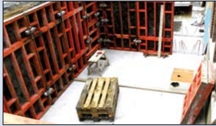
Här gjuts väggar till det nya rummet, här kommer det bli ett rum för barn och ungdom. 2015-04-17
