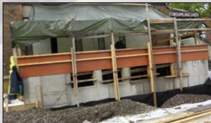
Ett våningsplan till har påbörjats samtidigt som man håller på med att öppna till hallen inmanför. 2015-05-19
