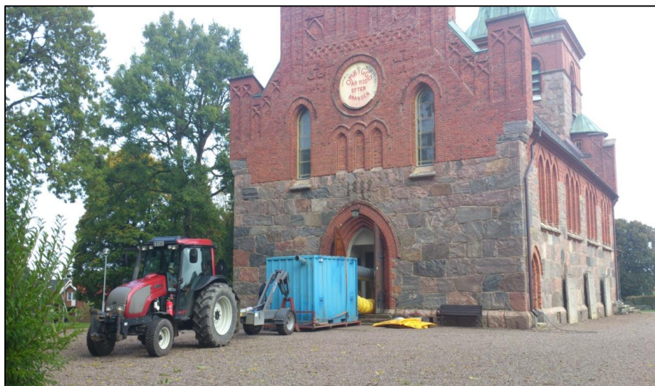
Figur 3: Test med varmluftskanon i Södra Kedum kyrka, Skara stift.
