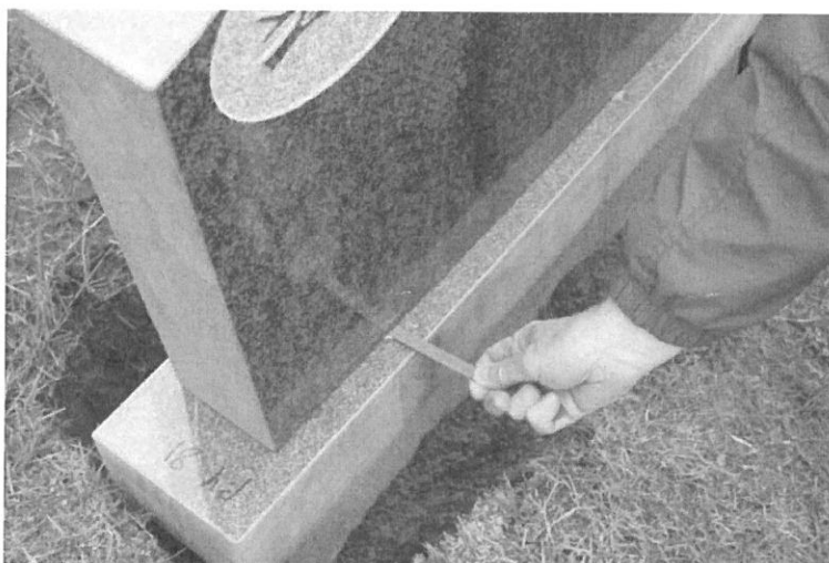
Figur 16. Kontroll av dubbar med bågfilmsblad.
