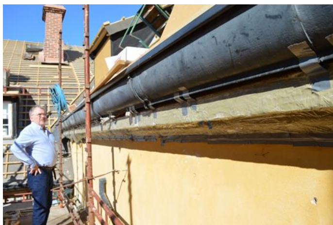
Inspektion! Pelle Sällström, Arkitektuset, anlitas under året som bygglédare för Domprostgårdens yttre renowering. På bilden inspekterar han hängrännor och den pågående rengöringen av takfoten.
