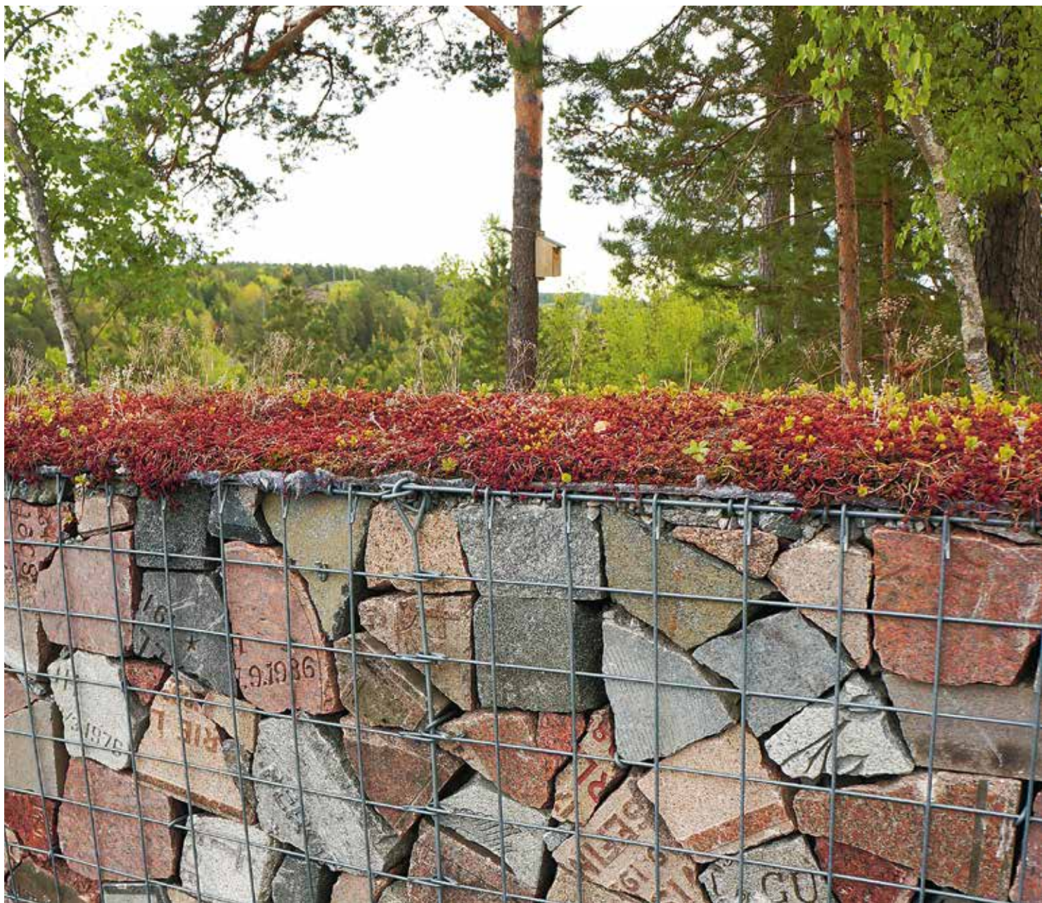
Den här vackra muren har byggts upp på Boo kyrkogård av stål-gabioner som fyllts med gamla gravstenar.
