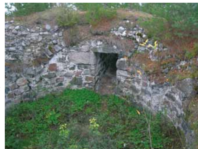
Interiörbild av kastalens bottenvåning, som är förvånansvärt välbevarad. På väggarna kan man se lämningar efter ett valv. Bottenvåningen kom man till via en trappa från andra våningen. Trappan, som finns kvar, är anlagd i den 3 m tjocka ytterväggen.
