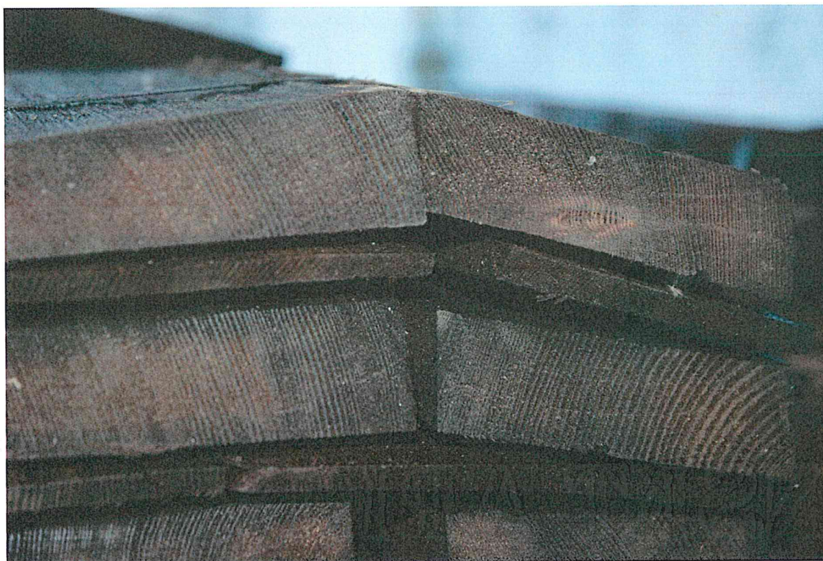
Tjärdoppade furuspån efter leverans från Vanhat Talot. Genomsnittlig årsringstäthet uppskattad till 8-12 årsringar per cm, även om enstaka spånor är mer snabbvuxna.
