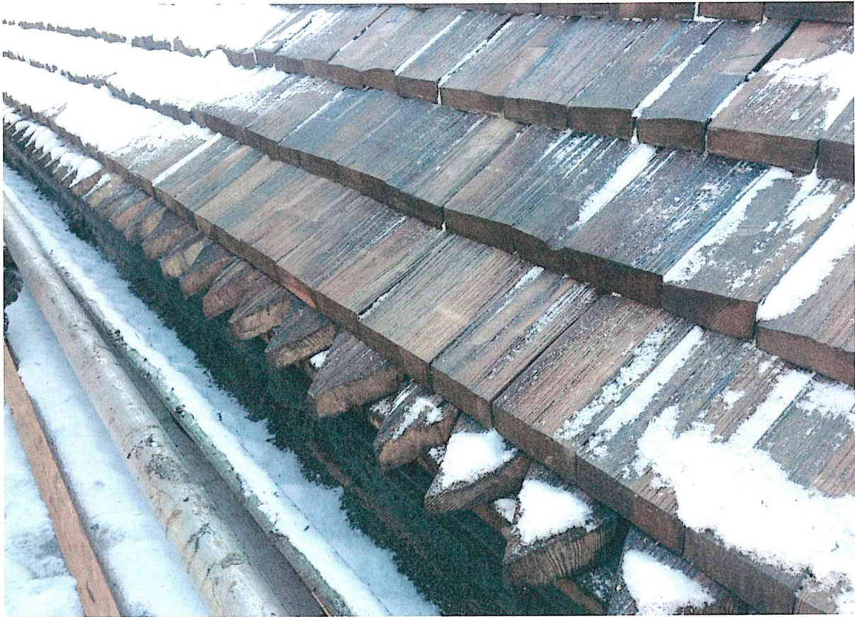
Del av det omlagda östra takfallet, februari 2016 (foto: Fredrik Olofsson).
