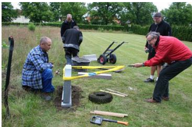
Figur 25 och 26. Gro-sockeln med synlig sockel. Stabilitetskontroll av montaget på GRO-sockeln.
