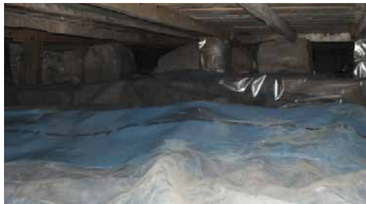
Bild från krypgrunden, Råneå kyrka
