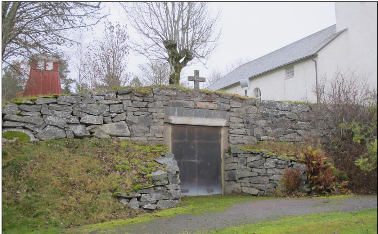
Rännelanda källarbårhus från 1945 är inkomponerat i en befintlig terrassmur. Foto: Västarvet.
