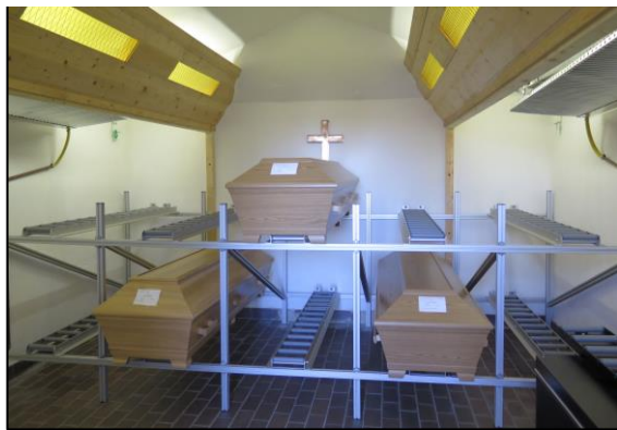
Dals-Eds bårhus har fått en modern och rationell inre ombyggnad som dock i stor utsträckning har låtit 1950-talets volym och ytskikt få finnas kvar, "bakom" den nya inredningen. Foto: Västarvet.
