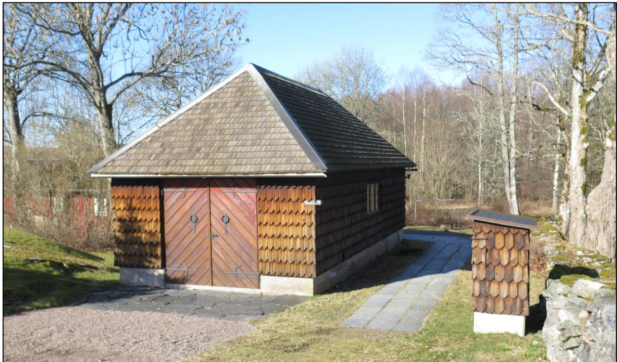
Fröskogs f.d. bårhus från 1948-1950 är byggt i trä. Exteriören är anpassad till den spåntäckta 1700-talskyrkan. Foto: Västarvet.
