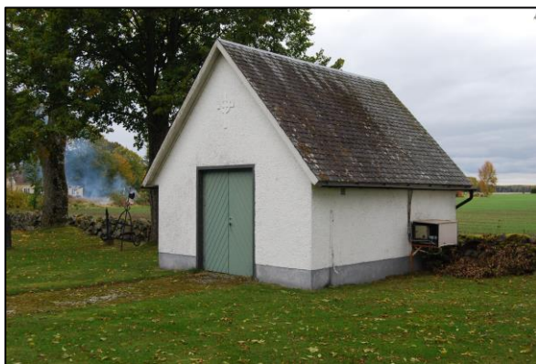
Grinstads f.d. bårhus från 1952-1955 har fått ny funktion som nodbod för ortens elförening. En ändring som kräver få ingrepp i befintlig byggnad. Foto: Västarvet.
