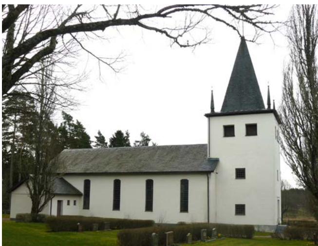
Lagmansereds nya kyrka, uppförd 1934-35 på ny plats.
