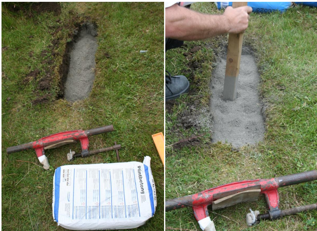
Figur 27 och 28. Provgjutning med betong för platsgjutning. Flera olika blandningar finns i handeln.
