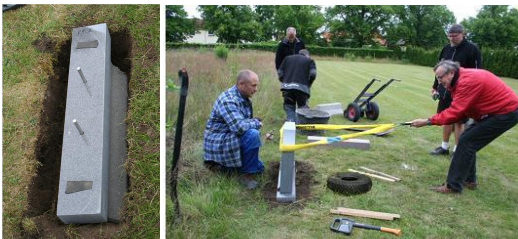
Figur 25 och 26. Gro-sockeln med synlig sockel. Stabilitetskontroll av montaget på GRO-sockeln.
