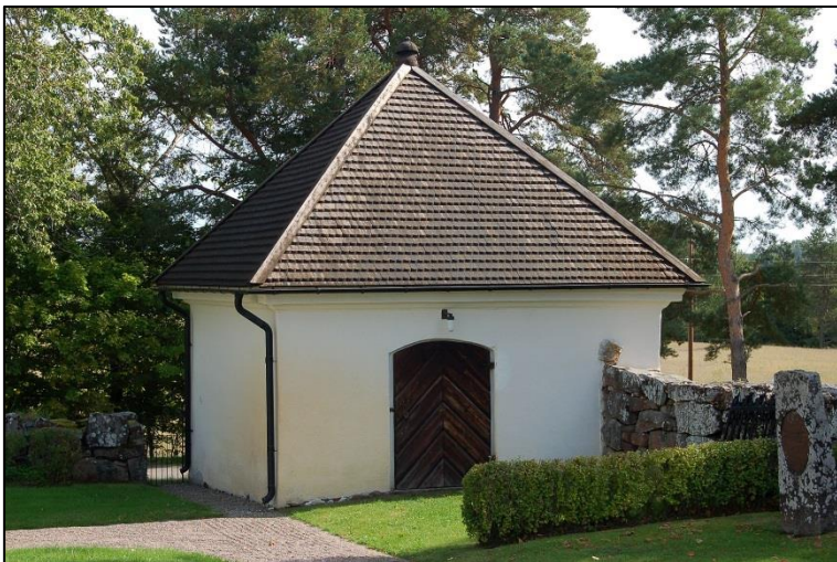
Bårhuset i det sydöstra hörnet tillkom vid 1777 års utvidgning av kyrkogården. Utanför muren reser det sig i två våningar med ingång till källaren från öster. Väggarna är murade och putsade.
