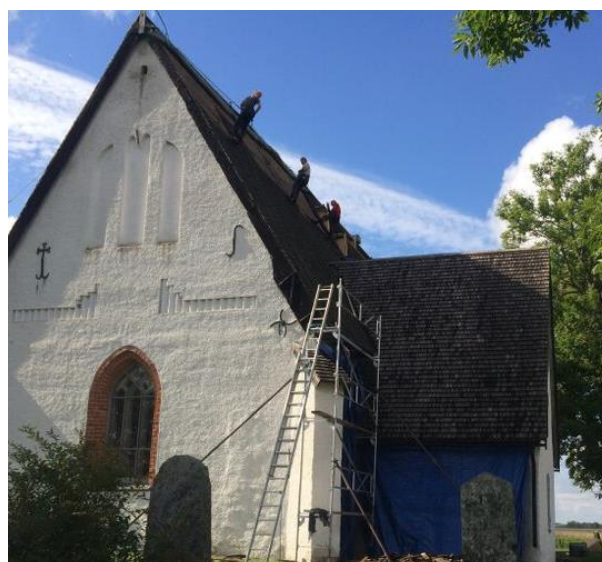
Omläggning av spåntak på Långtora kyrka.
