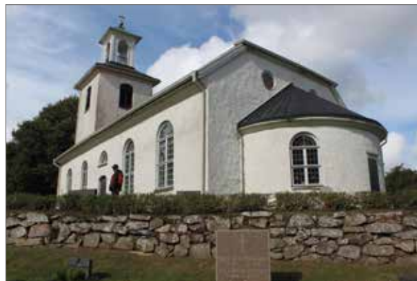
Stödmuren runt terrassen från sydost.
