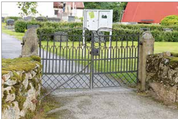
Smidd grind från 1888 vid den östra entrén.
