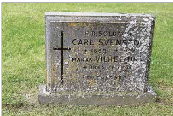
Kraftigt lavangripen sten gravnummer 83/Kv.4. Lavar som dessa är svåra att få bort på djupet utan att stenen skadas.
