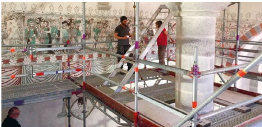
Öppet hus i Ganthemens kyrka 24 maj. Byggnadsarbetare Gundemar Lindahl berättar för en av besökarna om kyrkans restaurering. Foto: Rebecka Svensson.
