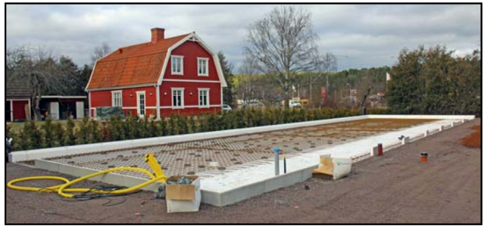
Så här såg förrådsbyggnadens grund ut den 2 mars 2017. Foto: Kent Käfling
